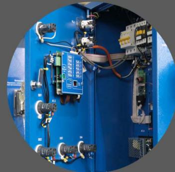
**Электронная система** синхронизации подъема и опускания автомобиля с помощью запатентованных датчиков абсолютного измерения высоты. Разность высоты на стойках подъемника не превышает 60 мм, независимо от нагрузки, приходящейся на каждую стойку.
